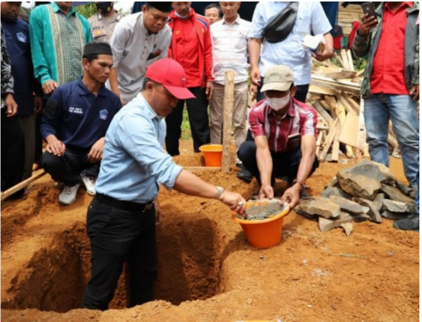
Peletakan batu pertama masjid at taqwa
